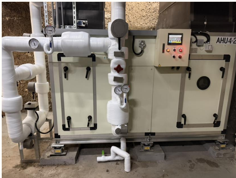
冷氣空調箱汰換
