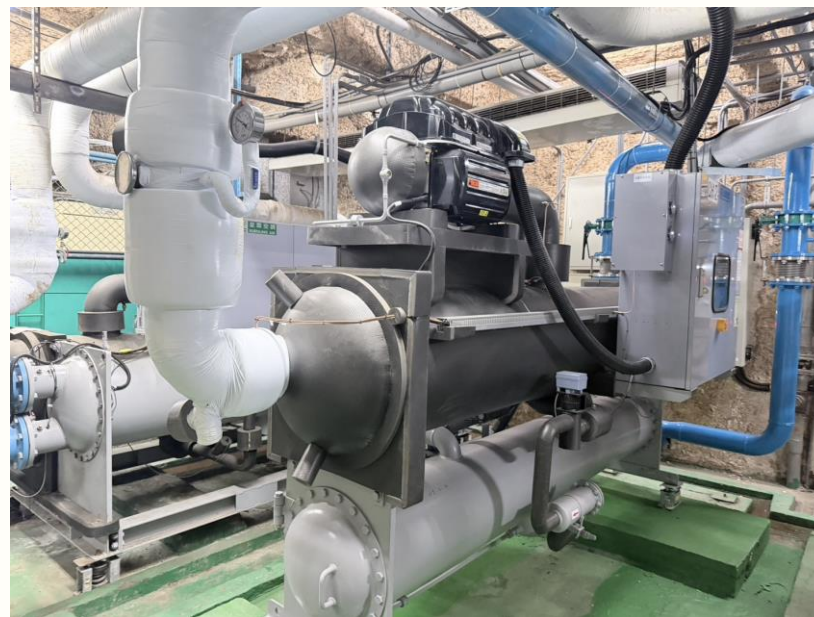
冷氣冰水主機汰換
