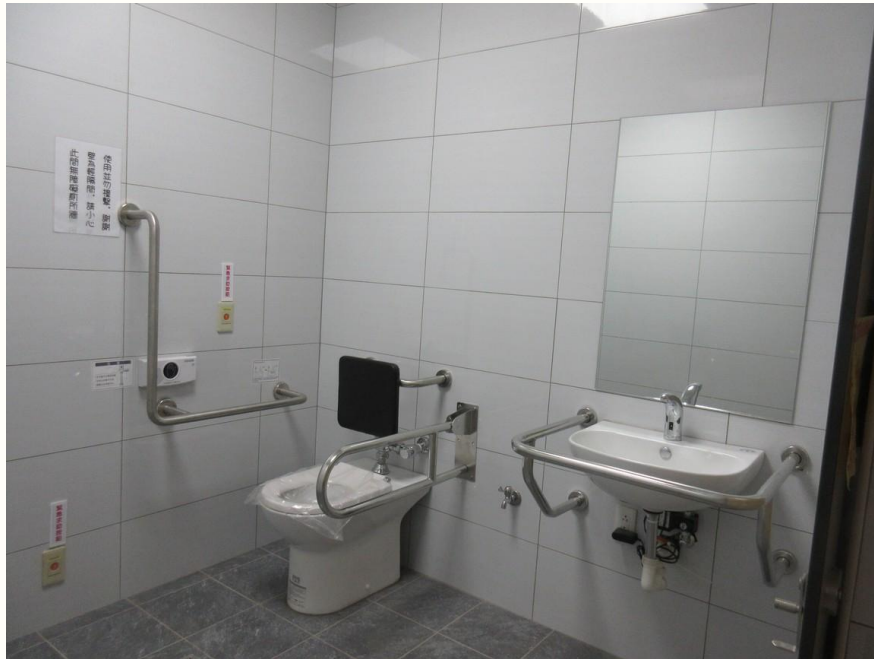
圖資大樓無障礙廁所改善 (114年1月完工)
