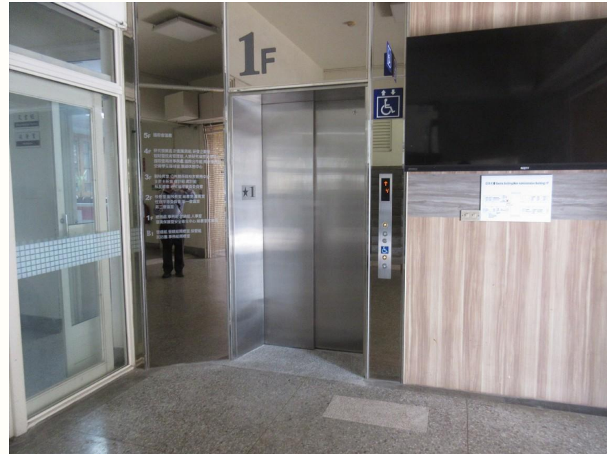
白沙大樓無障礙電梯更新 (114年12月完工)
